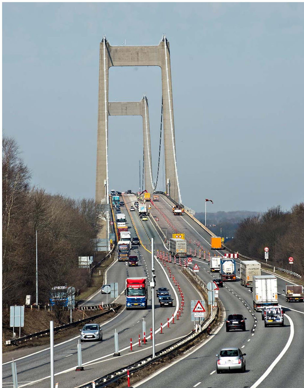
Vedligeholdelsesarbejde på Lillebæltsbroen.
