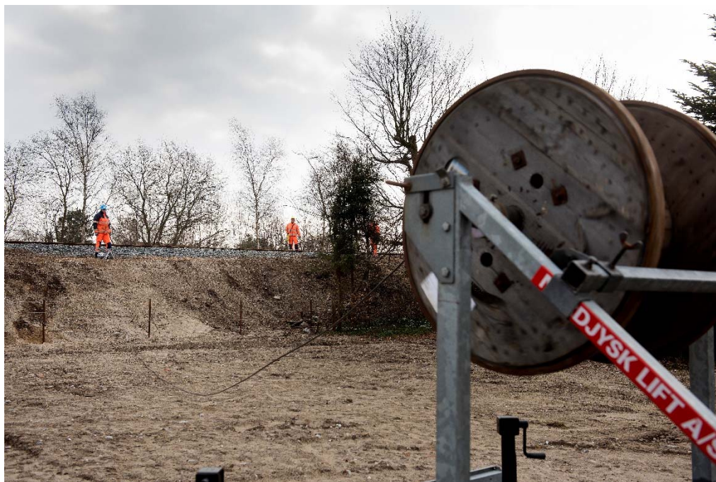
Arbejde ved sporstrækning i forbindelse med Signalprogrammet.
