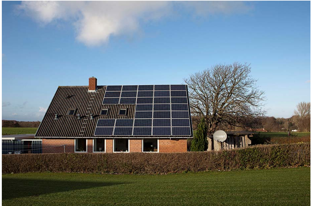
Husstand med et solcelleanlæg på taget svarende til ca. 6 kW.
